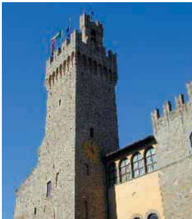
Torre del Palazzo dei Priori (Comune)
